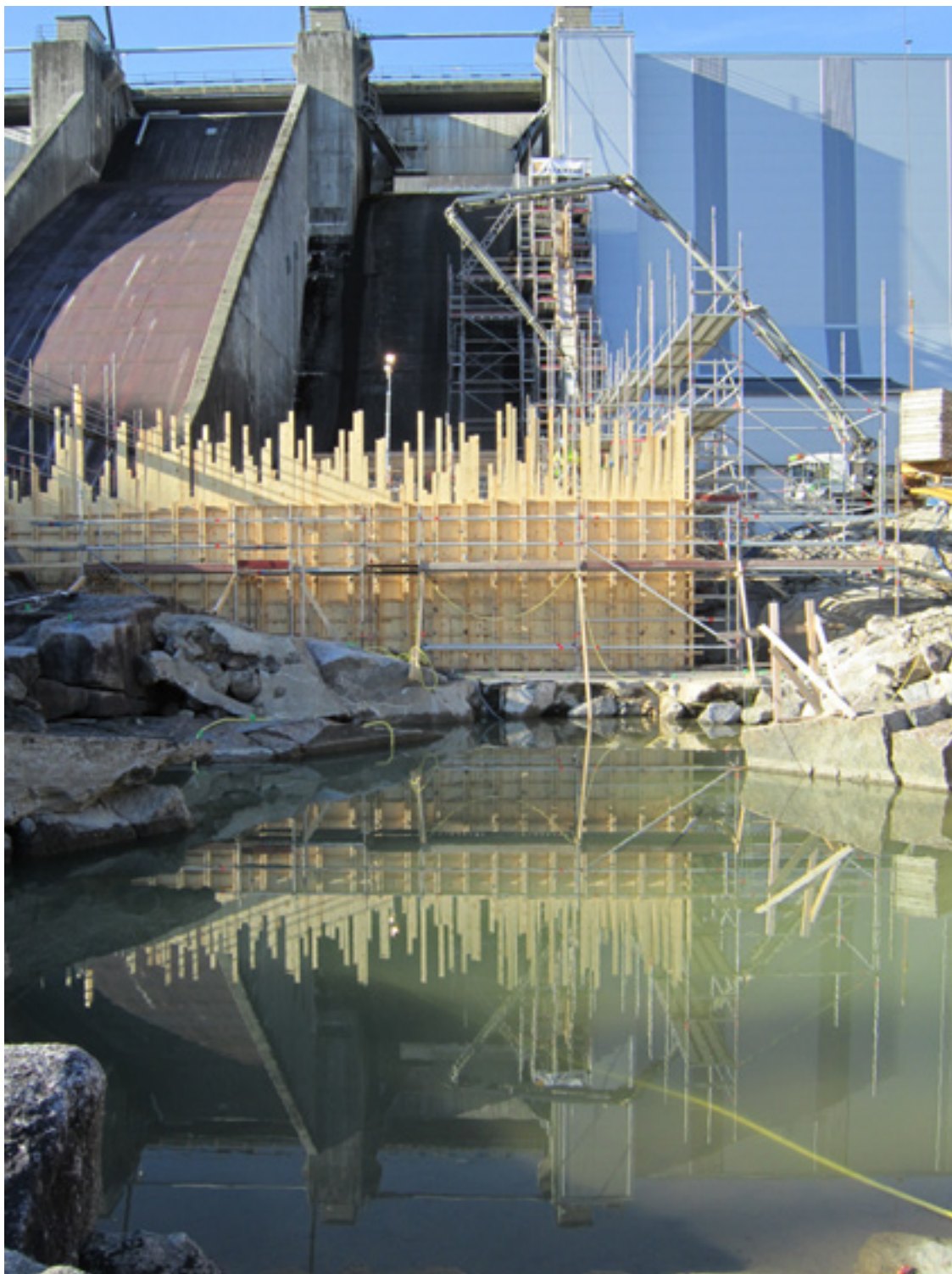
SKIBORDRENOVERING RAMSELE KRAFTVERK 2016
